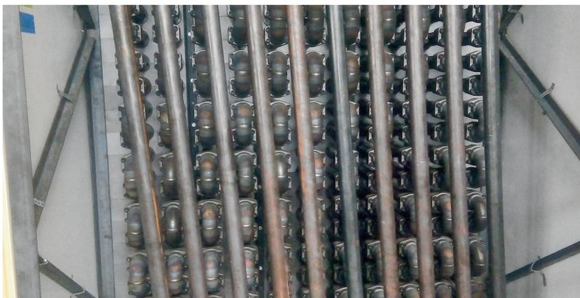
Fig. 3 Der Karbonisierungsreaktor besteht aus einem Rohr, das in 11 Schleifen von jeweils 12 Metern Länge angeordnet ist und insgesamt 5600 l Schlamm fasst. Der Reaktor ist sehr gut isoliert, sodass der Schlamm auf seiner vierstündigen Reise durch das Reaktorrohr nur 10 Grad (von 200 auf 190 °C) abkühlt. Im Reaktor verwandelt sich der Klärschlamm in Kohleschlamm, der nach dem Verlassen des Reaktors in einem Wärmetauscher auf 60 °C abgekühlt und in einer Schneckenpumpe entspannt wird.
