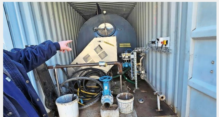
Fig. 6 Substratlagerung der Pilotanlage.
